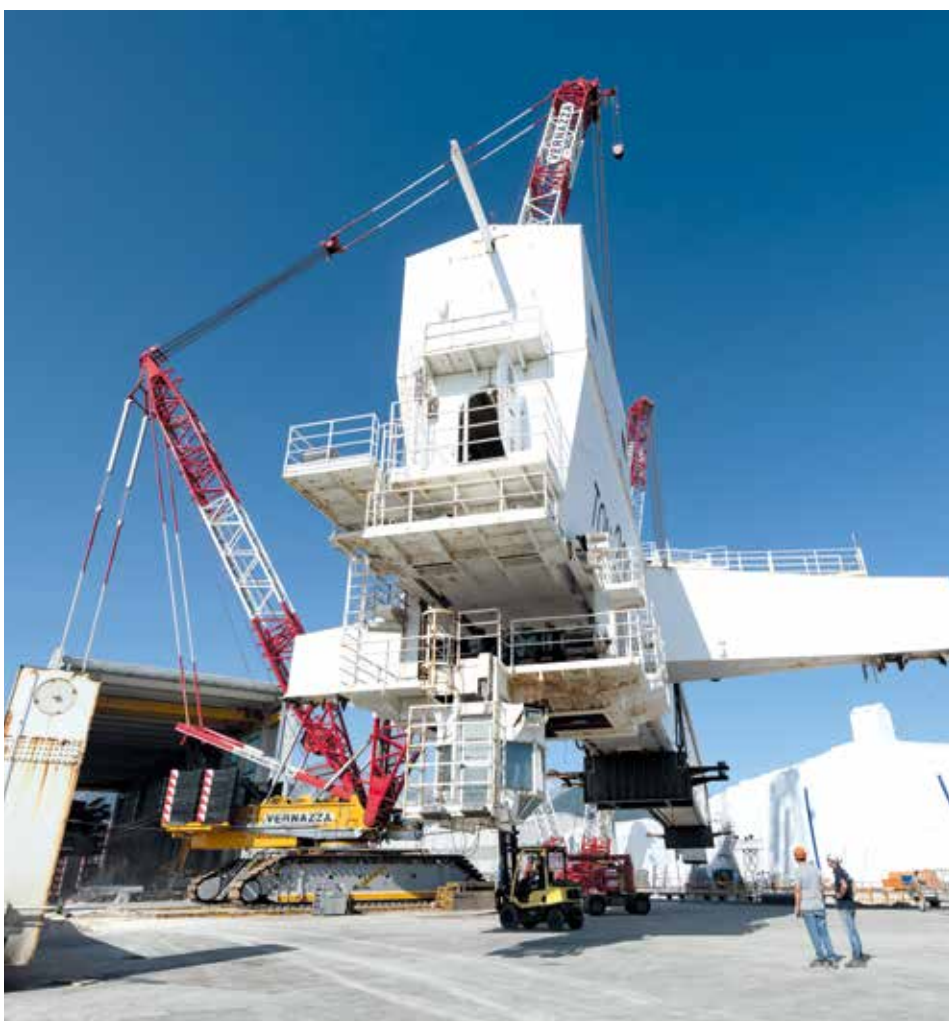
Zwei Raupen auf verschiedenem Niveau: der CC 3800-1 arbeitet aus dem Hafenbecken mit längerem Ausleger.
