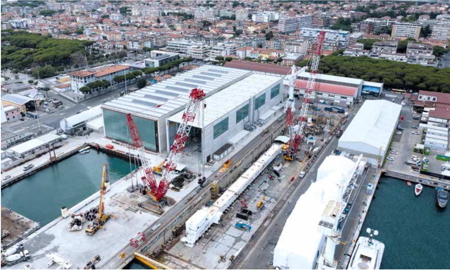
Tandemhub in der Marina di Carrara: links CC 3800-1 und rechts CC 6800.
