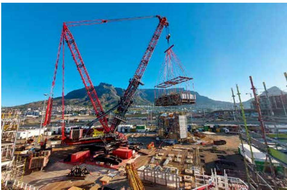
In einem dreiwöchigen Einsatz wurden alle Module auf dem Deck des 177-Meter-Schiffs installiert.
