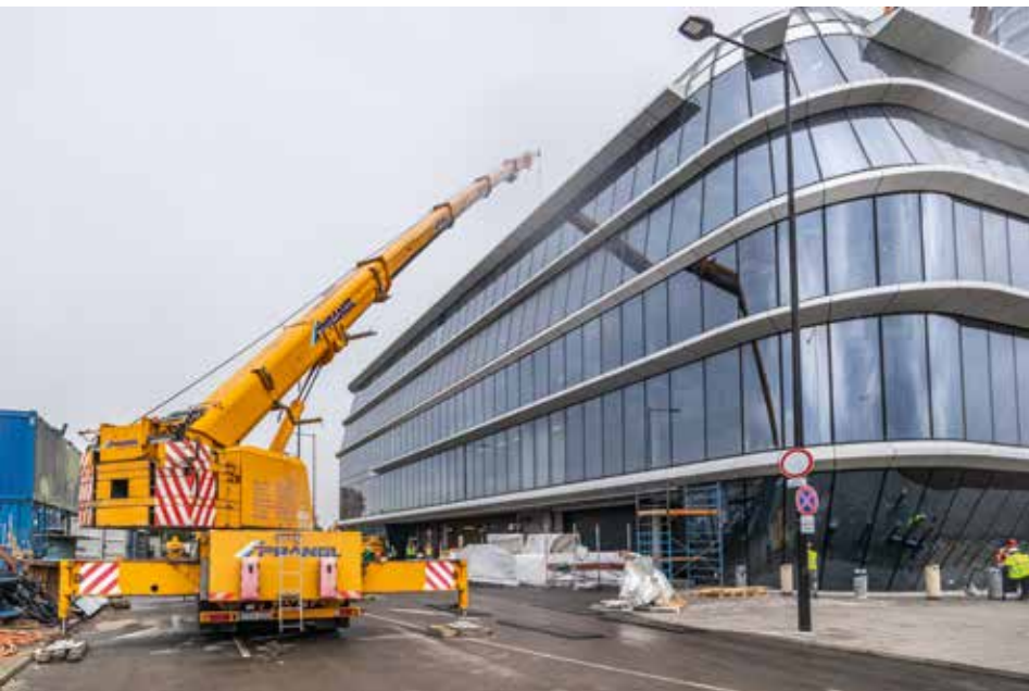
Einhub von Fassadenteilen an neuem Bürohaus in Budapest.
