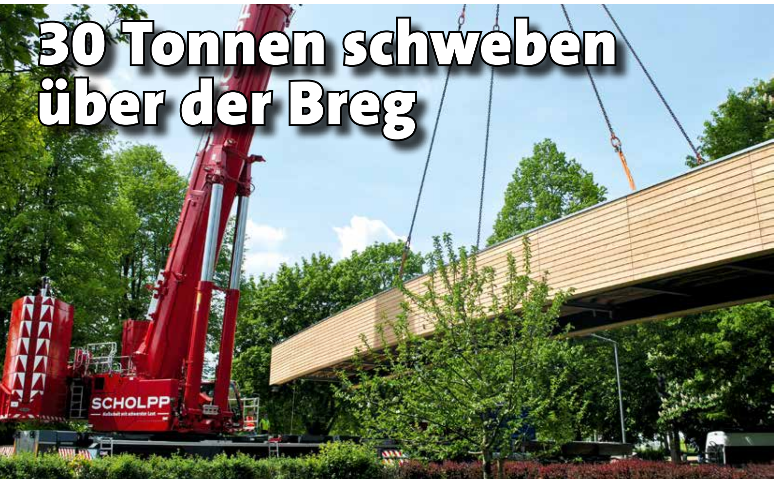
Die 30 Tonnen schwere Brücke am Haken des LTM 1650-8.1 von Scholpp.
