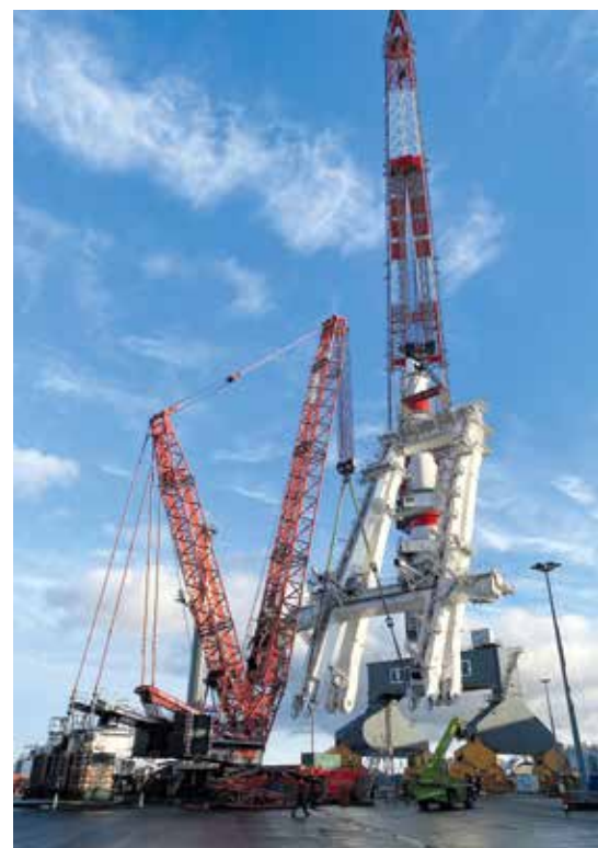
Heavy Lift des A-Frame.
