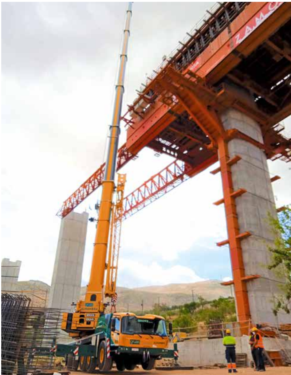
Grove GMK5250L von Grúas Alhambra unterstützt den Bau einer Brücke für Hochgeschwindigkeitszüge in Loja, Granada.
