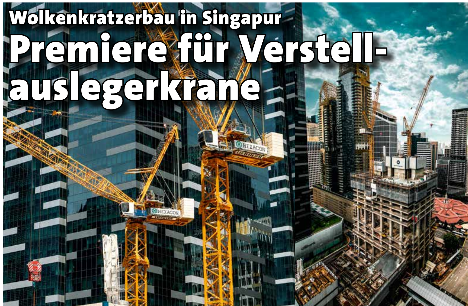
Zwei Verstellausleger-Krane von Liebherr beim Bau einer der beiden Türme der Central Boulevard Towers in Singapur.
