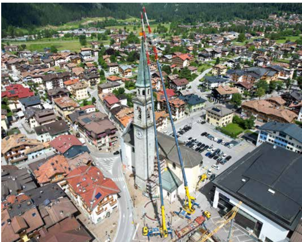
Reparatur-Einsatz in mehr als 72 Metern Höhe.
