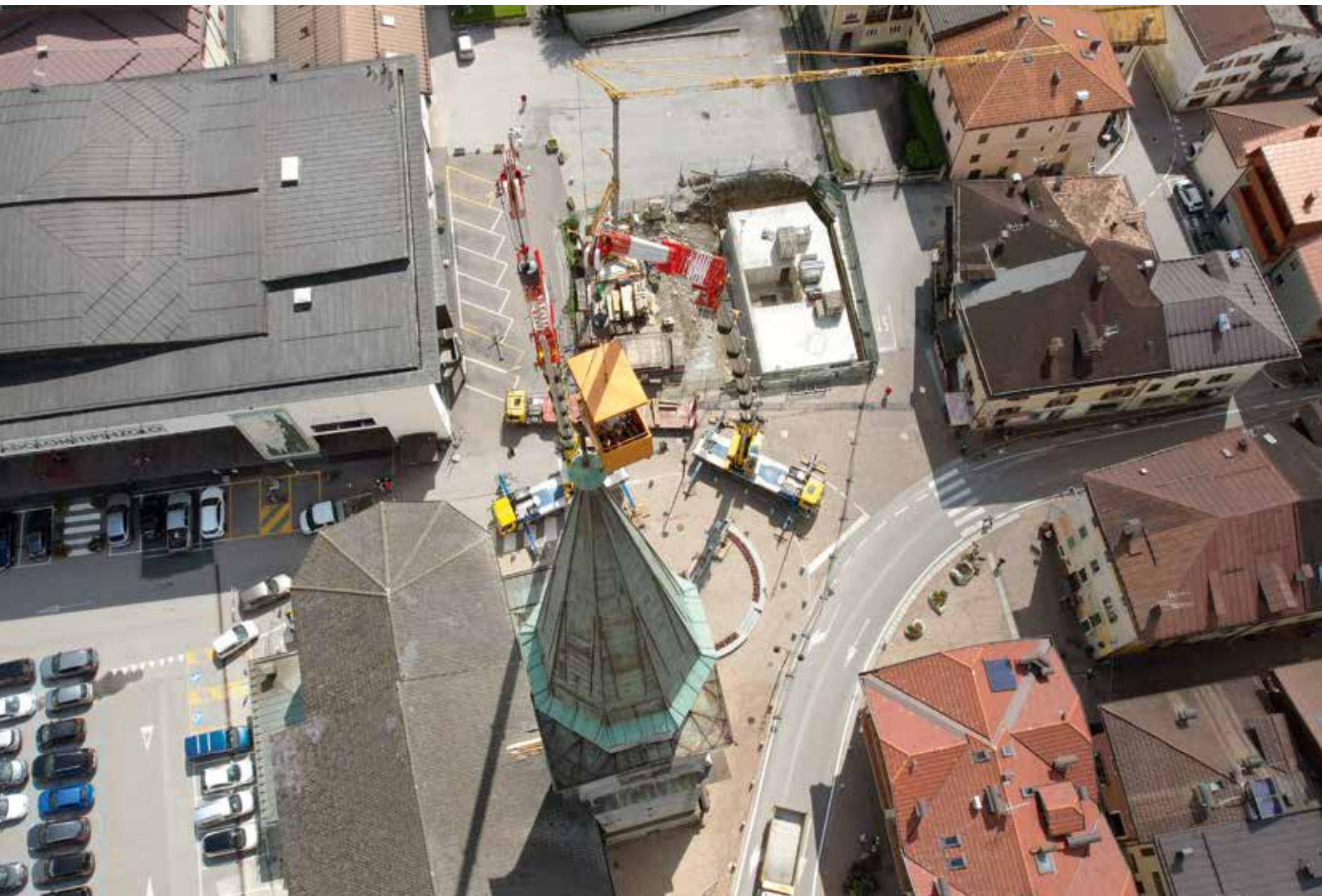
Kran als Arbeitsbühne. Aus der Gondel am Haken des GMK wird das Kreuz auf dem Kirchturm von San Lorenzo repariert.
