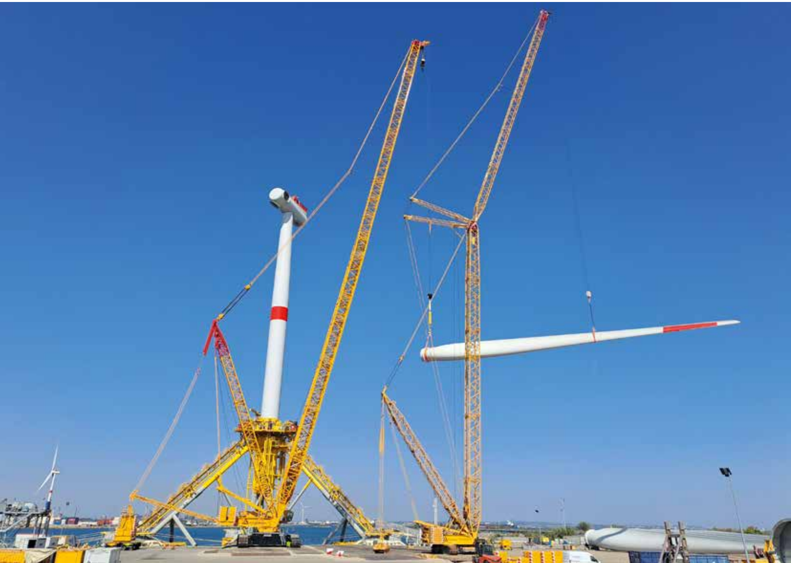
Schmidbauer-Raupen montieren WKA an der südfranzösischen Küste.
