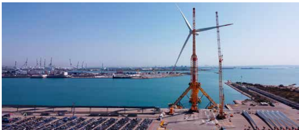
Totale über den Montageplatz in Fos-sur-Mer.
