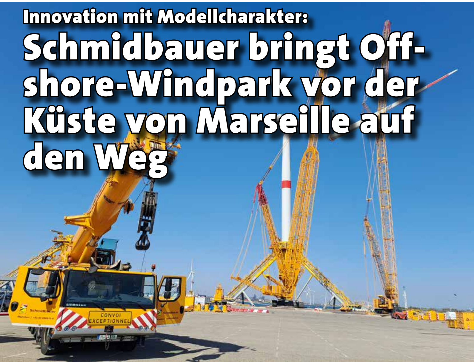
Der erste Flügel einer zu errichtenden WKA wird eingehoben.
