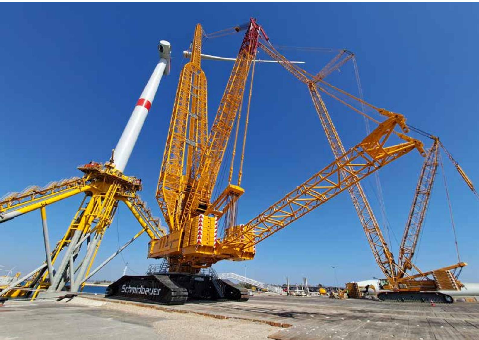
Spezialmontage per Raupenkran auf einem später schwimmenden Fundament.
