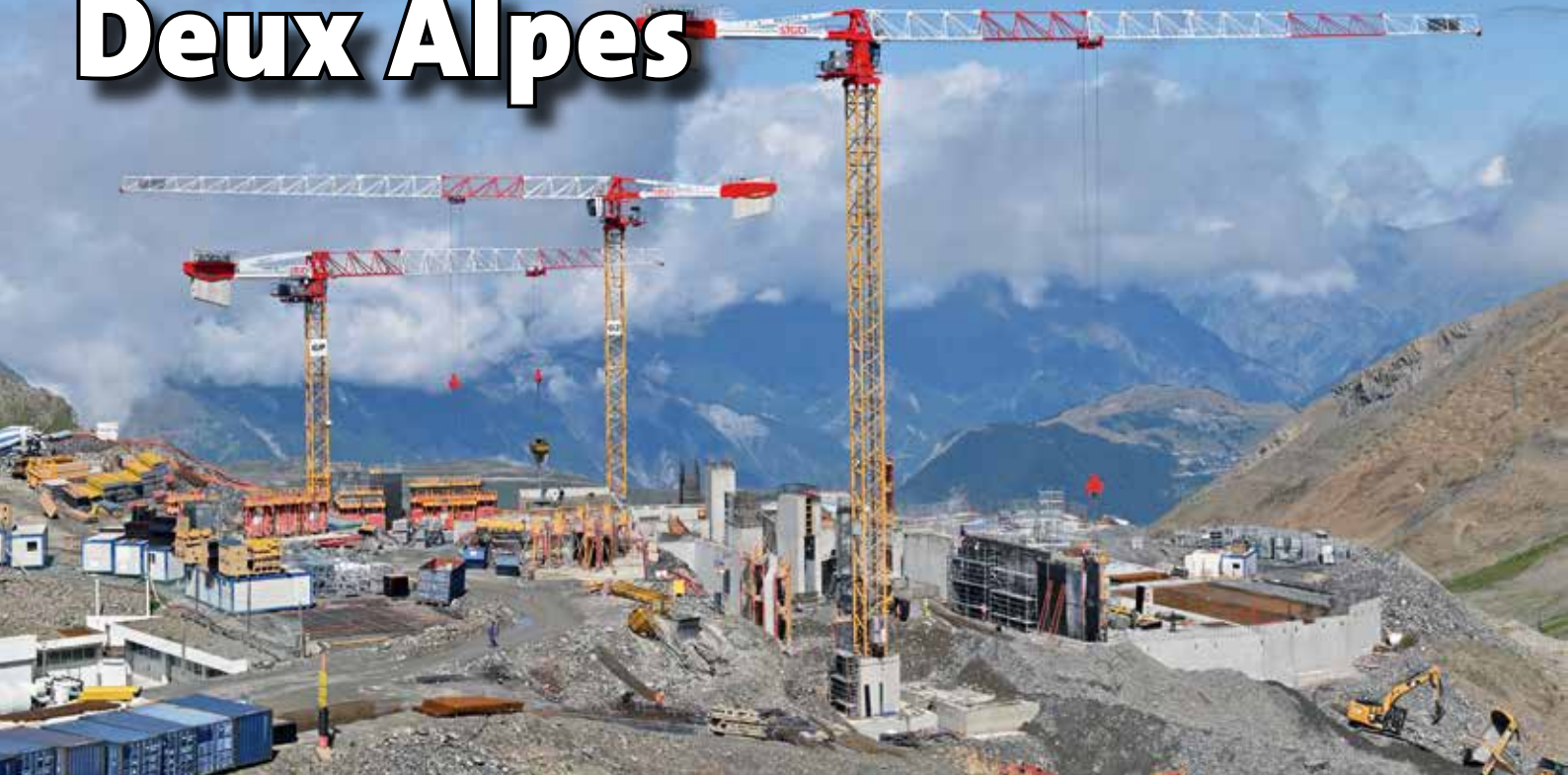
Potain-Krane im Einsatz auf der Seilbahn-Baustelle 3S Jandri Express.
