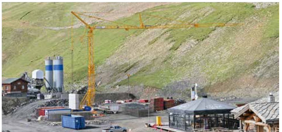
Jeder Kran hat eine spezielle Aufgabe: Hier die Entladung und Umladung von Material zur Versorgung der verschiedenen Standorte.
