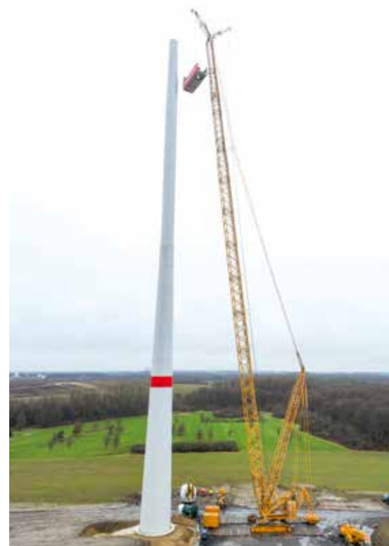
Einhub des Maschinenhauses auf 164 Metern Höhe.
