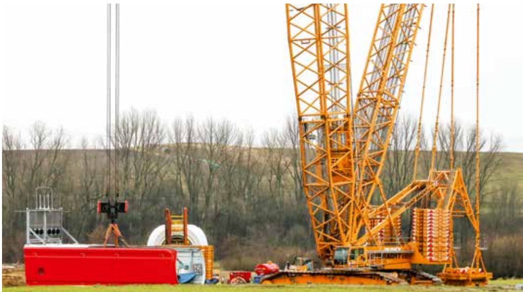
Das Maschinenhaus, noch am Boden.
