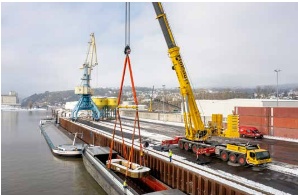
Bei über 15 Meter Ausladung versenkt der Liebherr-Kran die 115 Tonnen schwere Bruttolast im Schiffsbau.
