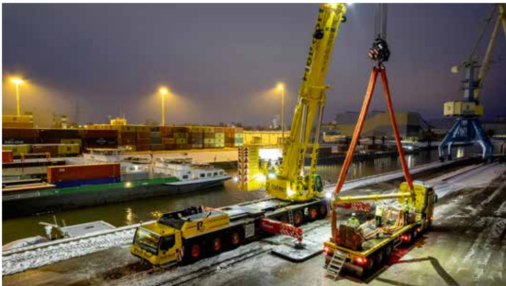
Etlliche Strahler am Ausleger und Oberwagen erlauben auch Arbeiten bei Dunkelheit.
