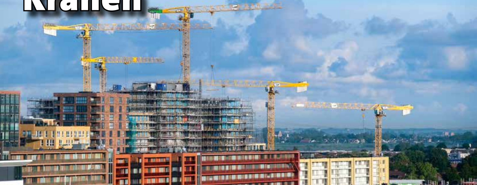
Sechs MDT-Topless-Turmdrehkrane von Potain im Einsatz beim Bauprojekt "De Zaanse Helden".
