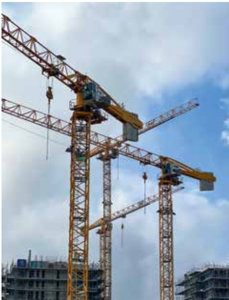
Multi-Crane und Stebru Bouw stimmten gemeinsam die Hakenhöhen und Positionen der Krane ab.
