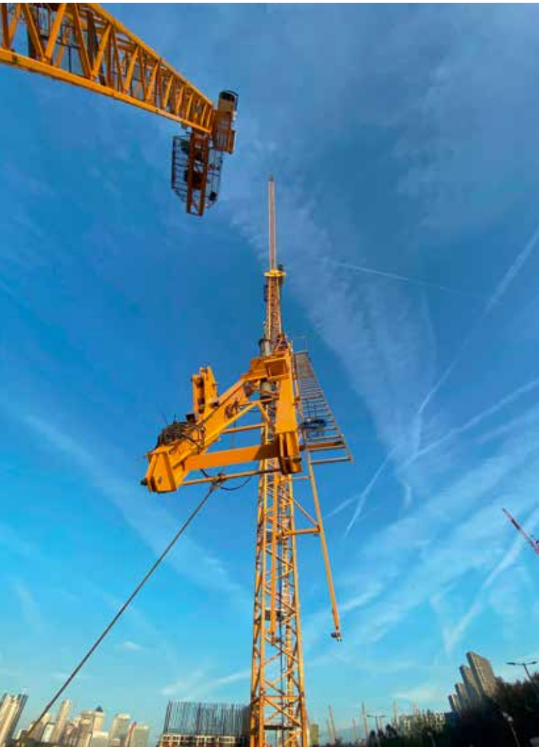
Aufbau des ersten MR-229 Wippauslegerkrans mit CCS-Steuerung in London.
