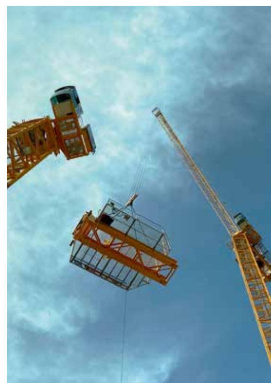
Montage des Gegenauslegers am Potain MR 229.
