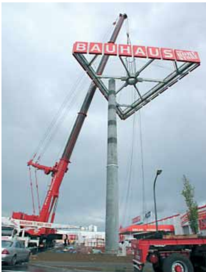
Fingerspitzengefühl war gefragt, denn die Last pendelte stellenweise bedenklich nah Richtung Ausleger. KM-Bild
