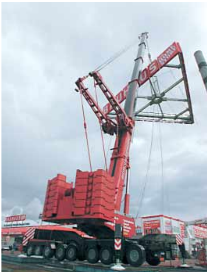
Mit 140 t Ballast kam der AC 500-1 in Oggersheim zum Einsatz. Gut zu sehen ist, dass der seitliche Superlift hier eher als „normaler“ Superlift eingesetzt wurde. KM-Bild
