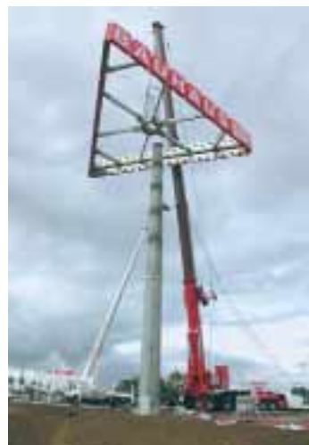
Von einer Lkw-Arbeitsbühne aus erhielt der Kranfahrer genaue Anweisungen. KM-Bild
