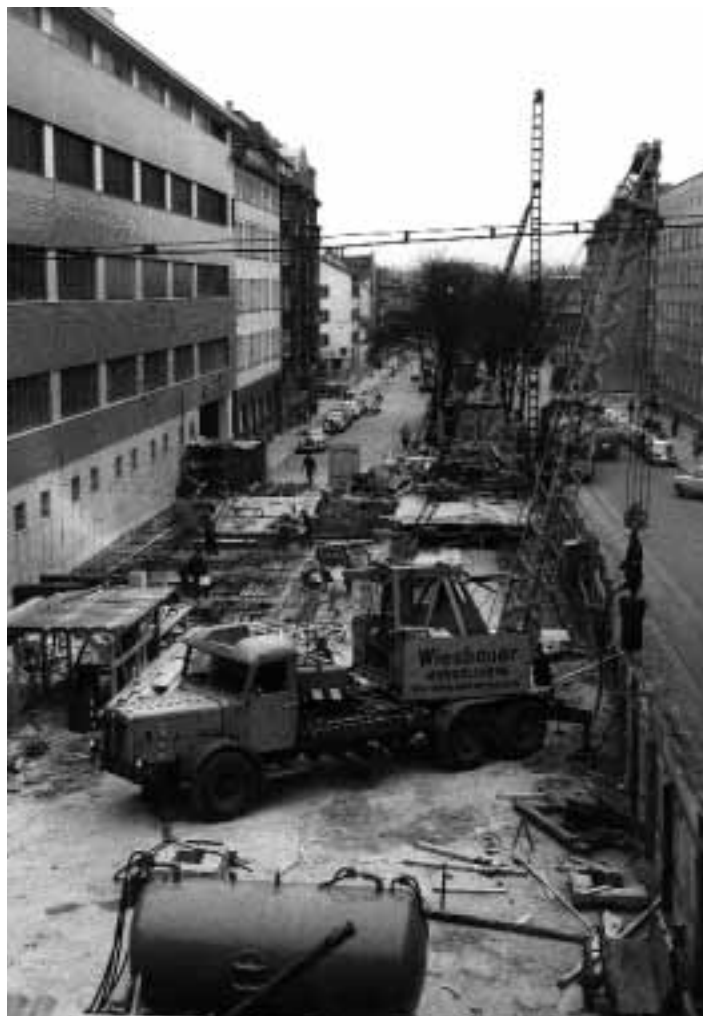
1959, vier Jahre vor der Gründung der BSK. Der erste Kran der Wiesbauer GmbH & Co. KG ist ein auf ein gebrauchtes Lkw-Chassis aufgebaute Kässbohrer-Kran.
