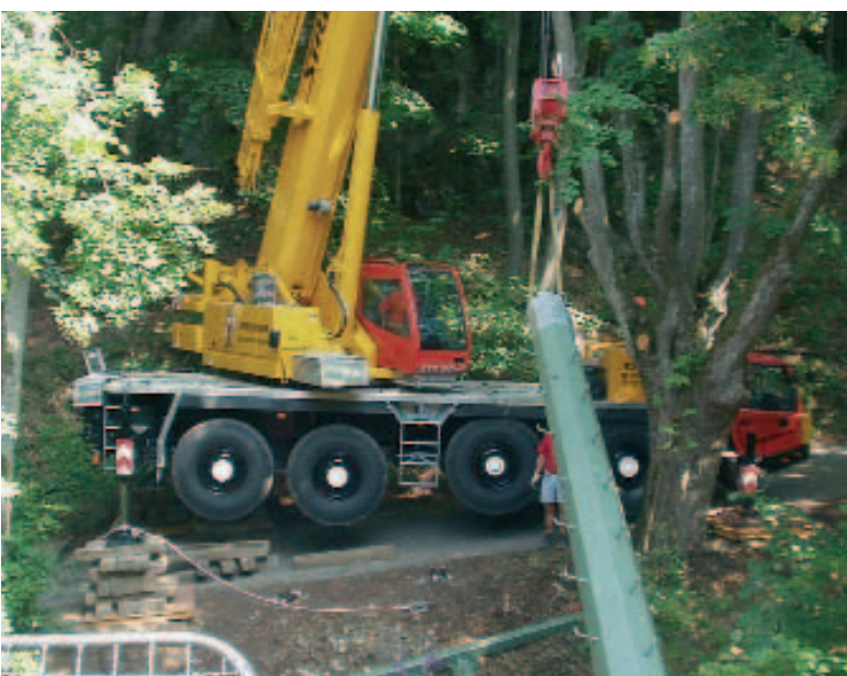
Vor lauter Bäumen und hinter dem Strommast kaum zu sehen: der ATF 90-4 der Firma Strohmeyer, der direkt an einer steilen Böschung aufgestellt werden musste.
