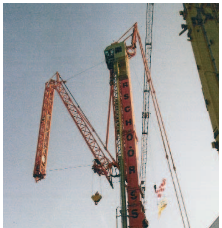
Ein „Falter“ in Aktion: Bis dahin sind rund 10 Minuten vergangen, und in etwa 5 Minuten kann gezogen werden. KM-Bild
