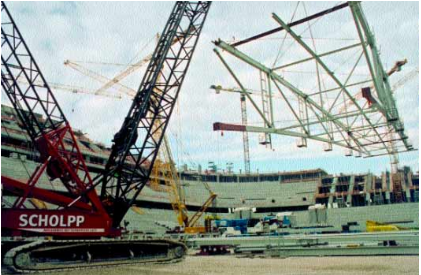
Dank der Beweglichkeit und Wendigkeit des Demag CC 2500 mit der Scholpp-Bezeichnung RK 500 ist es möglich, die im Innenraum der Allianz Arena zusammengeschaubten zwölf Mittel- und 24 Seitenstützen der Dachkonstruktion anzuheben und dann präzise an die gewünschte Position im Stadion-Oval zu hieven.
