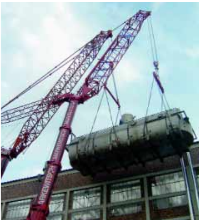
Auch nach dem „Nadelöhr“ im Dach blieb es eng bei diesem Hub.
