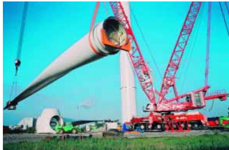
Montage des Flügelsterns. Jedes Rotorblatt der gigantischen Anlage misst 61,5 m und wiegt 18 t.
