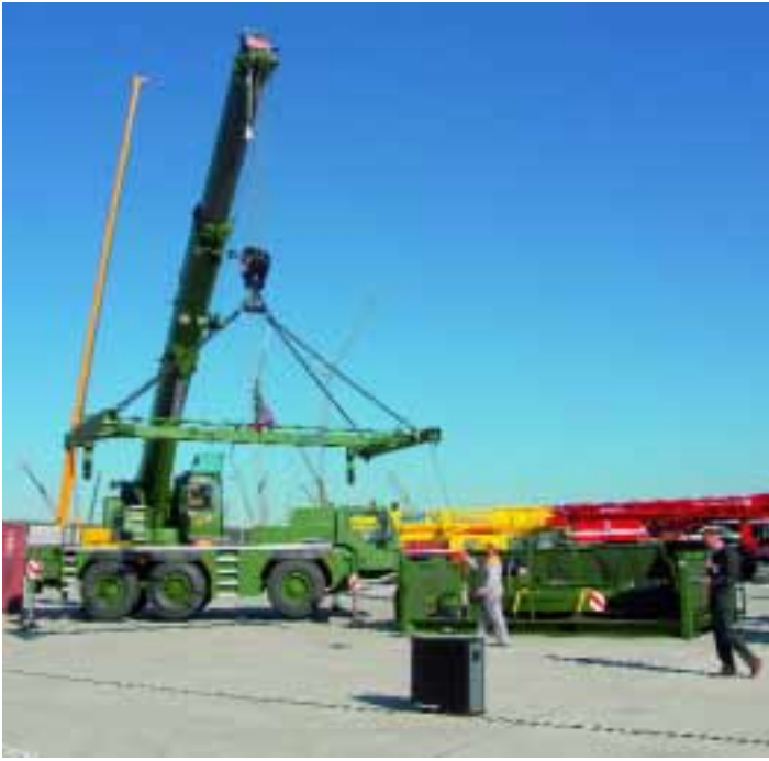
Containerhandling mit 20'-Spreader. Für das Umladen von 40'-Containern stehen auch schwere Kettengehänge zur Verfügung. KM-Bild
