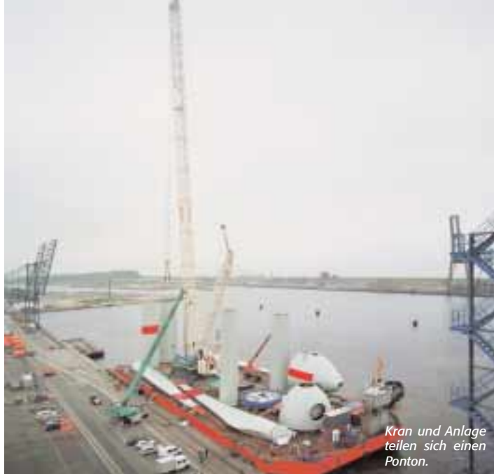
Mit insgesamt 138 m Systemlänge kam der CC 8800 zum Einsatz.
