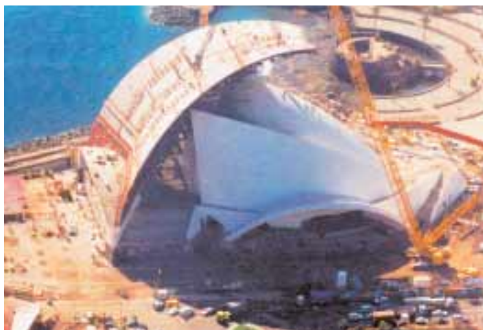
Einsatz auf Teneriffa beim Anheben des Auditorium-Daches. Neben der Positionierung des Daches wurde mit SyncHoist – im kleinen Bild knapp unter dem Kranhaken erkennbar – auch die Schwerpunktlage der Last ermittelt.
