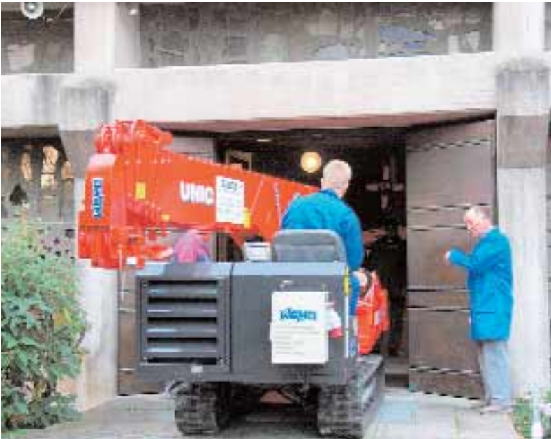
Mit 1,8 m Transporthöhe und 1,38 m Breite stellte die Eingangstür zur Kirche in Maberzell bei Fulda für den UNIC-Miniraupenkran URW-A506 CL E kein Problem dar.
