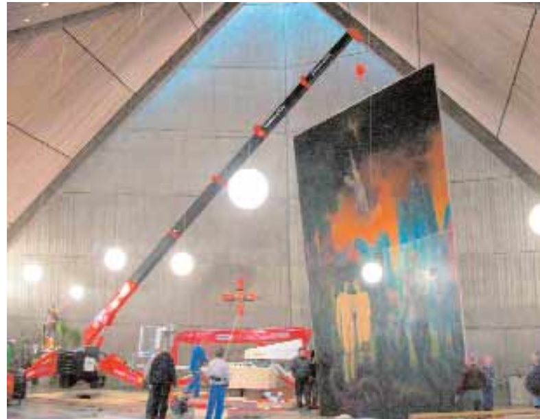
... das 12,8 m hohe und 8,2 m breite Ölbild einfach aufgehängt werden konnte. Eine Dachabdeckung und die Verwendung eines großen Mobilkrans war so überflüssig.
