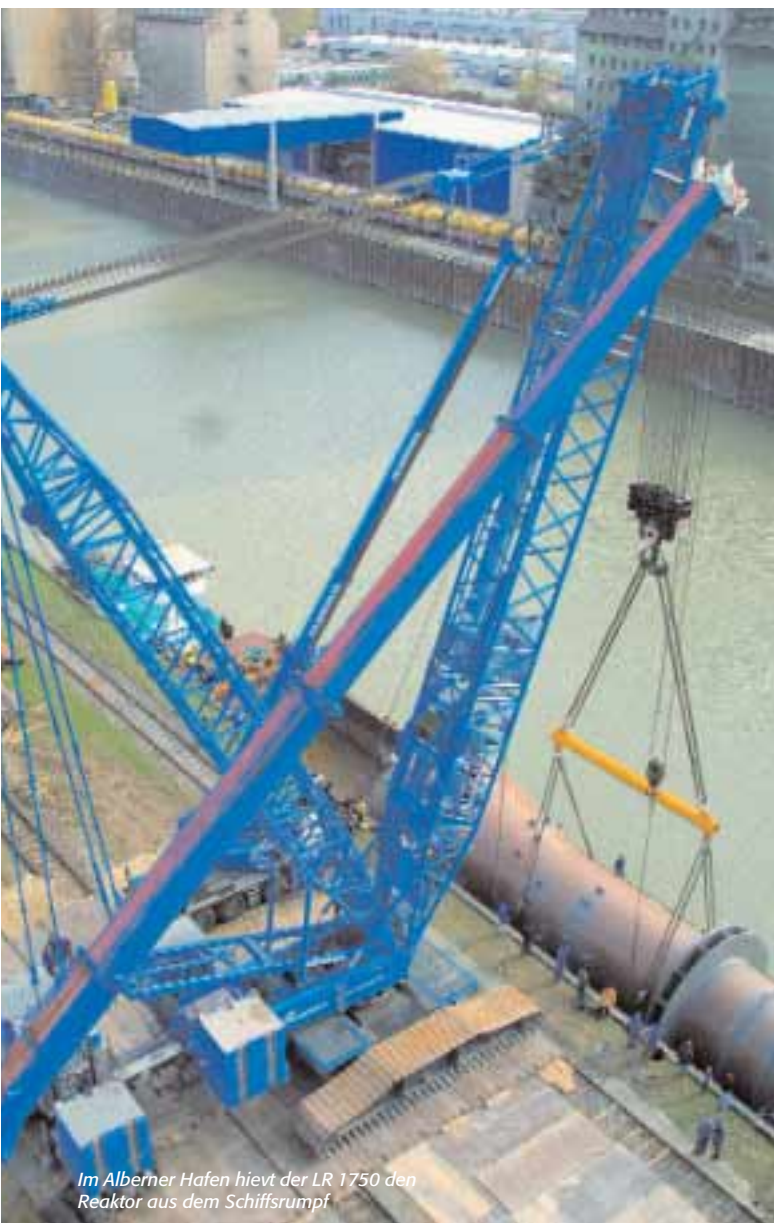
Eine Last der Superlative am Haken: 400 t schwer, 36 m lang und ein Durchmesser von fast 10 m.
