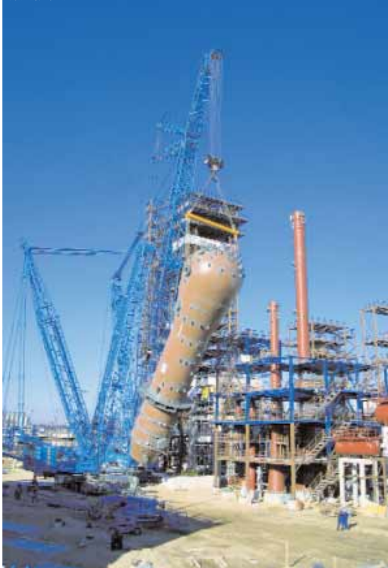
Eine Last der Superlative am Haken: 400 t schwer, 36 m lang und ein Durchmesser von fast 10 m.
