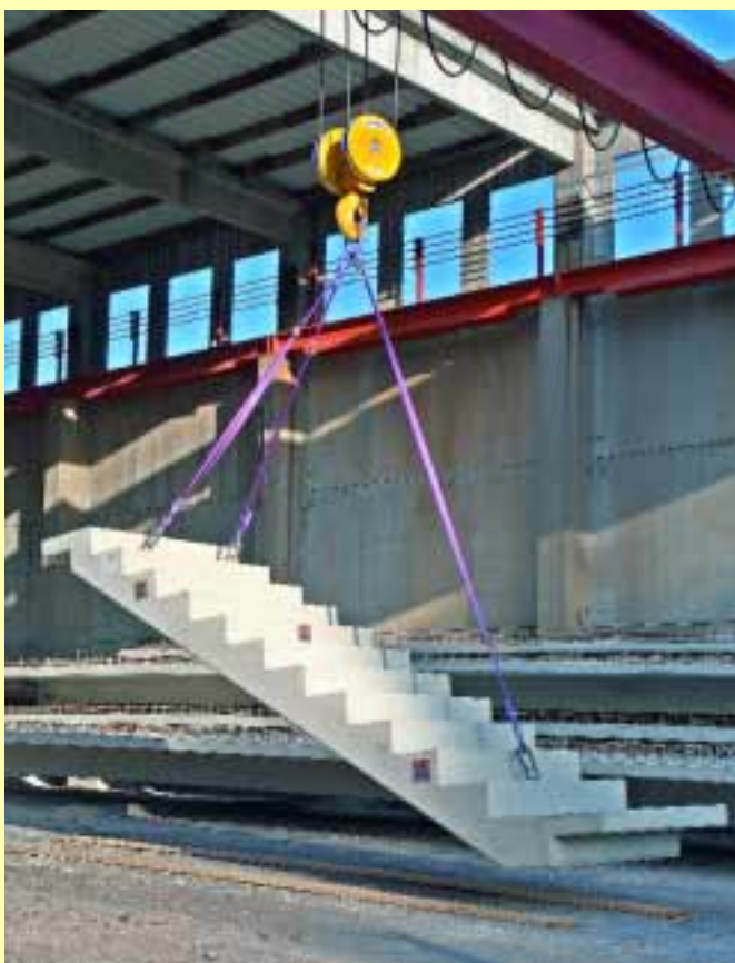
Textile Anschlagmittel zum Heben asymmetrischer Lasten. Dafür bietet SpanSet VarioWeb zur stufenlosen Längenverstellung von Gurtbandgehängen an. Standardmäßig wird VarioWeb in ein-, zwei- und viersträngigen Gurtbandgehängen eingebaut. Bild: SpanSet
