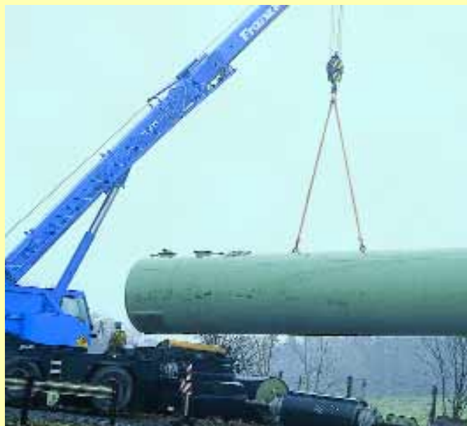
Ein-, zwei- oder mehrsträngig – Rundschnürlengehänge sind in jedem Fall leichter als Ketten oder Drahtseilgehänge und durch Sichtkontrolle sehr einfach gemäß BGR 500 überprüfbar. Bild: SpanSet
