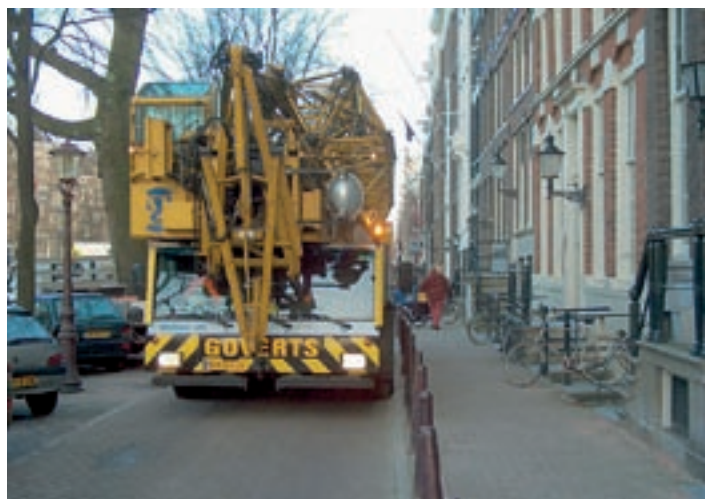
Wo man fahren kann, kann man auch arbeiten - so erklärt man bei Spierings die Vorzüge des Faltkrankonzepts.
