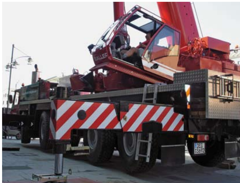
Bei dem Einsatz wurde dem Team von Kran Saller nicht nur Konzentration abverlangt, sondern auch eine funktionierende Kommunikation zwischen den Mitarbeitern war gefragt.
