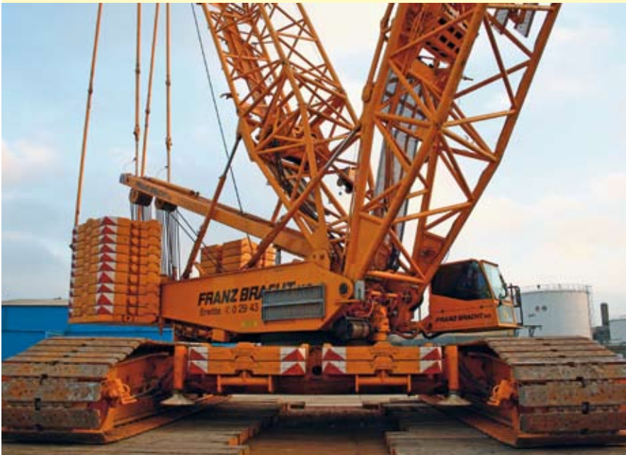
Der CC 2800-1 von Bracht im Einsatz.
