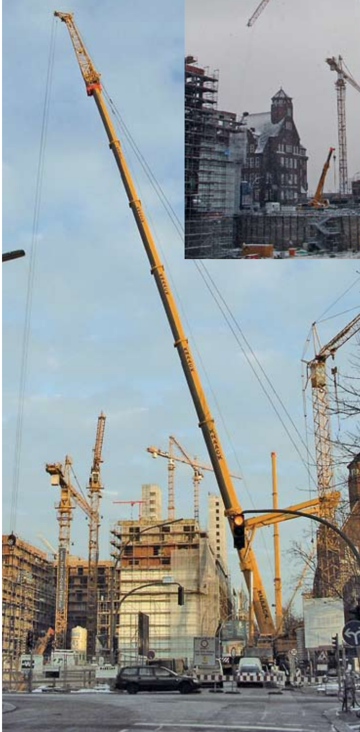
Der LTM 1500 von Knaack ist mit dem 84 m-Teleausleger ausgerüstet. Foto: Birger Hennig
