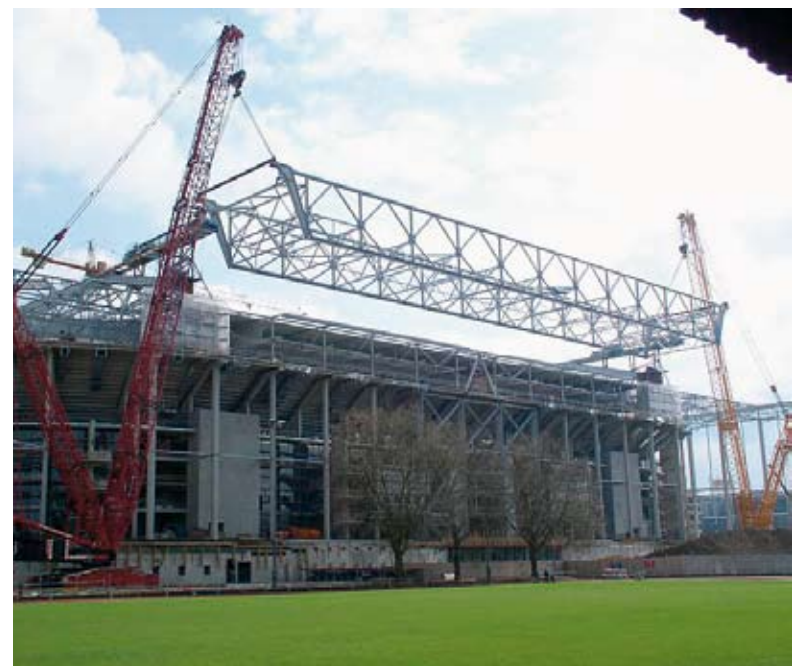
Tandemhub in belgisch / niederländischer Kooperation am Dortmunder Westfalenstadion. Bilder: www.schwerlast-nrw.de
