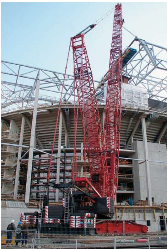
Tandemhub in belgisch / niederländischer Kooperation am Dortmunder Westfalenstadion. Bilder: www.schwerlast-nrw.de
