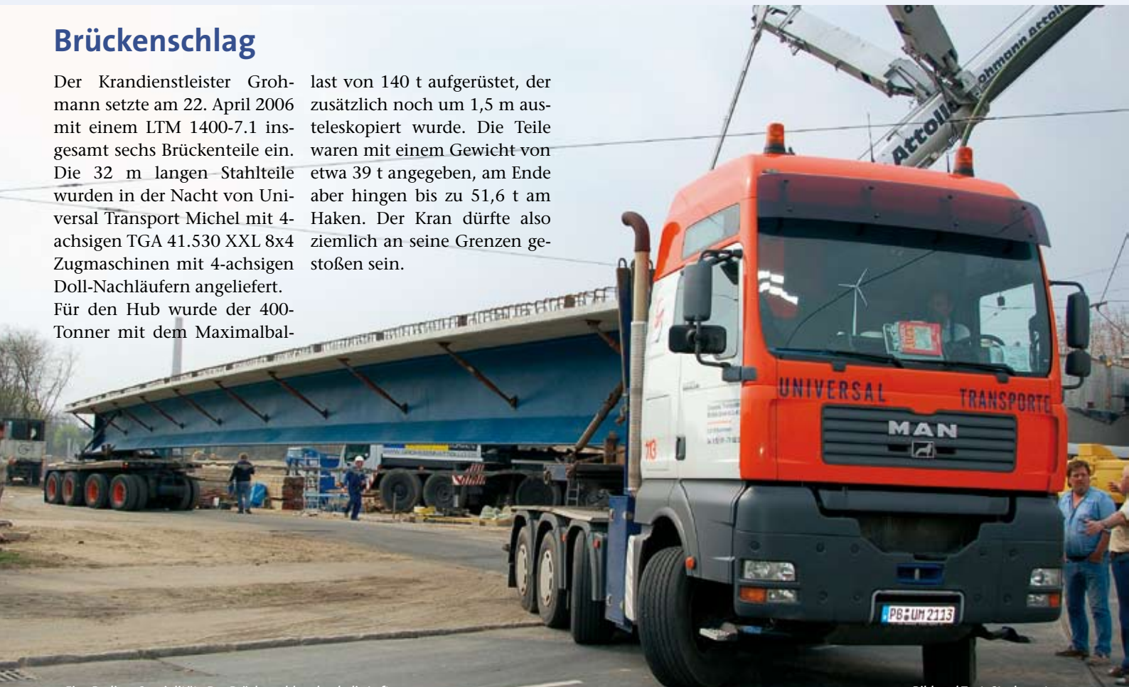
Eine Berliner Spezialität: Der Brückenschlag durch die Luft.
