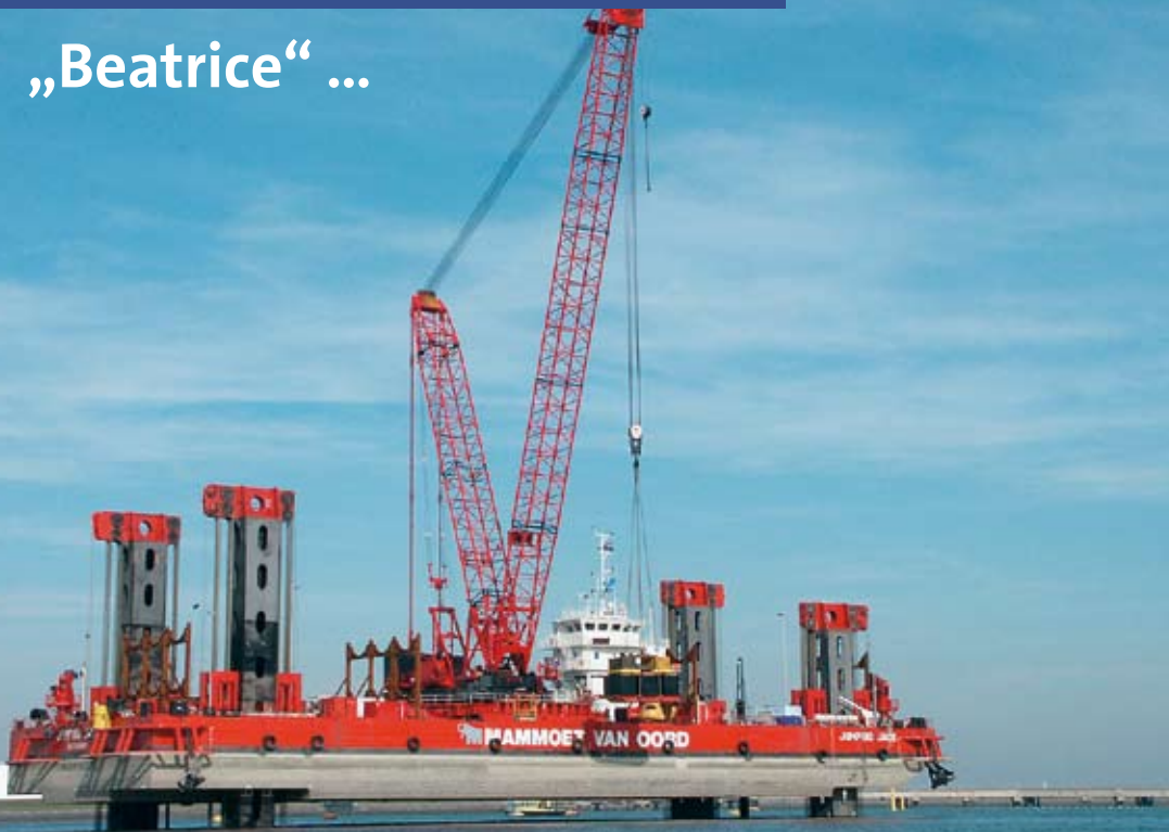
Einsatz für den „Jumping Jack“ – einem Schwimmkran mit Abstützungen.
