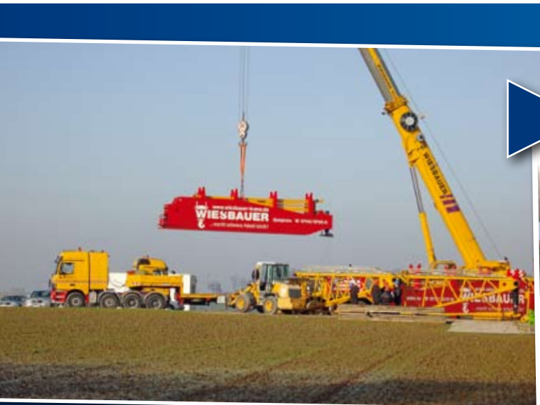
Per Hilfskran (GMK 5220) werden die Stützen angebaut.
