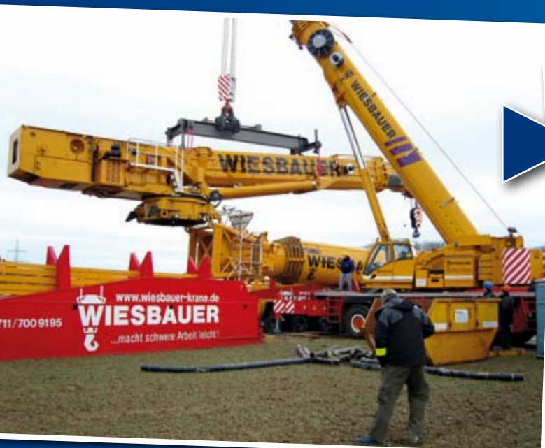
Montage des Oberwagens am Vertikalturm. Foto: Marco Wilhelm
