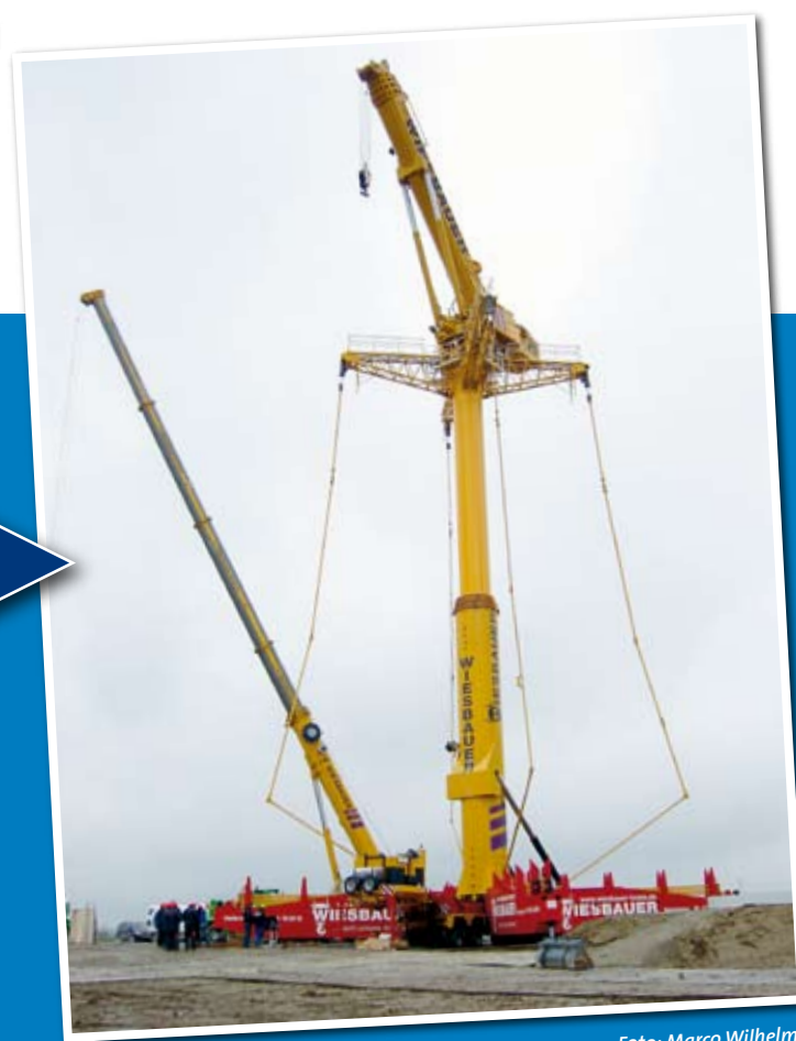
Der Vertikalmast wird auf 81 m austeleskopiert.
