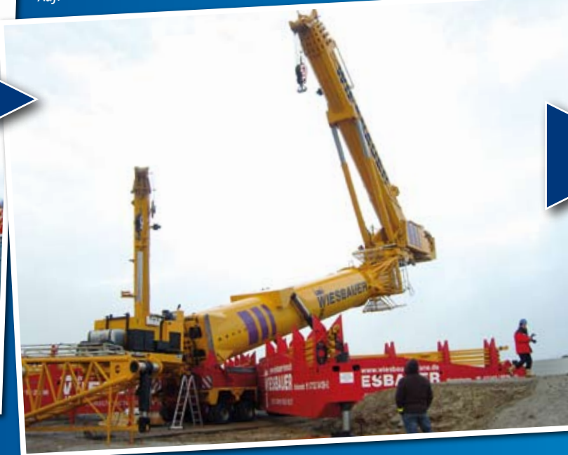
Aufrichten des Vertikalturms mit angebolztem Oberwagen. Foto: Marco Wilhelm
