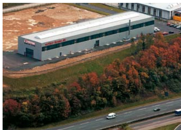
Die neue Fertigungshalle der Vetter Fördertechnik GmbH ist direkt an der Autobahn A45 gelegen.
