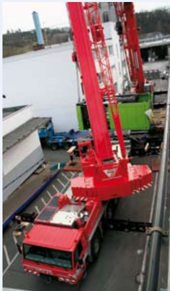
Tadano Faun ATF 160G-5 im Tandemlift mit dem Liebherr LTM 1200 beim Austausch einer 70 t Kunststoffpresse in Bogen.
