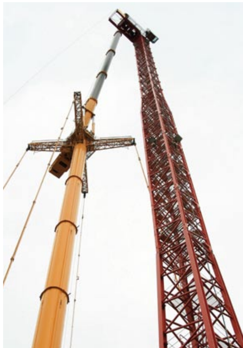
► Einsatz des GTK 1100 beim Rückbau eines Laufkatzenkranes und der anschließenden Montage eines Wippkranes: Alternativ zum GTK 1100 wäre selbstverständlich auch der Einsatz eines „normalen“ großen Autokranes mit Wippe möglich gewesen. Eventuell hätte man den Wippkran aber dann noch ein Stück weit klettern lassen müssen, bis die Turmhöhe von 112,95 m erreicht gewesen wäre. Der schwerste Hub der Montage war die komplette Turmspitze mit knapp 12 t. Der Einsatz in Lingen war der dritte Einsatz für den GTK 1100 und der erste Nicht-WKA-Einsatz.
