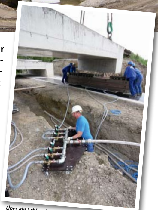
Über ein Schlauchsystem sind die Luftkissen mit dem Kompressor verbunden. Das zwischengeschaltete Ventilsystem ermöglicht eine Dosierung des Luftdrucks.
