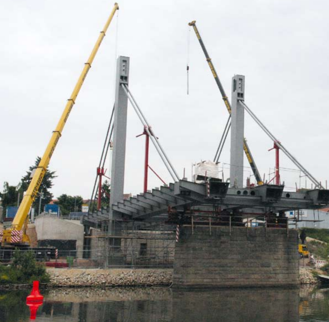
Am 27. Mai 2008 wurde das letzte fehlende Bindeglied der neuen Löwenbrücke - drei 25 m lange und 38 t schwere Längsträger - millimetergenau in die Stahlkonstruktion eingefügt. Foto: Stadt Bamberg/Presseteile
