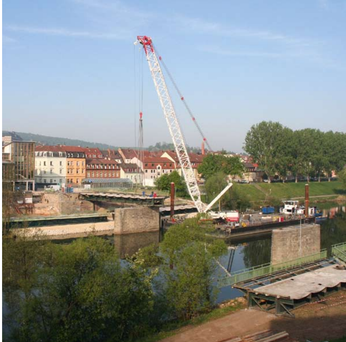
Rückblick: Im April 2007 wird die 1948 erbaute Löwenbrücke auf einem Schwimmkran aufgehängt, in sechs Teile zerschnitten, auf die Uferpromenaden gehoben und dort zerleinert. Die gesamte Stahlkonstruktion aus vier Längs- und zwölf Querträgern ist etwa 100 m lang und 14 m breit. Foto: Stadt Bamberg/Pressetelle
