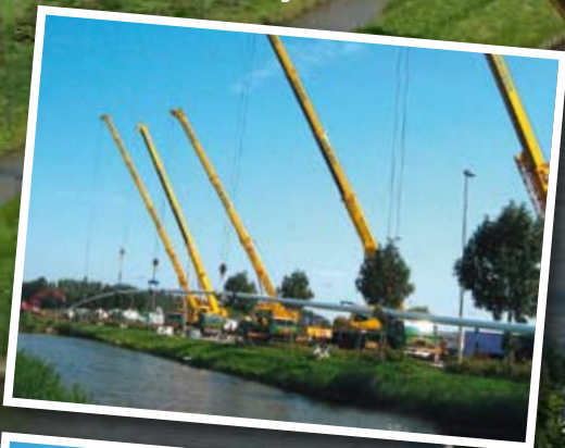
Sieben Tadano-Faun-Krane verlegen eine 425 m lange Gasleitung.
