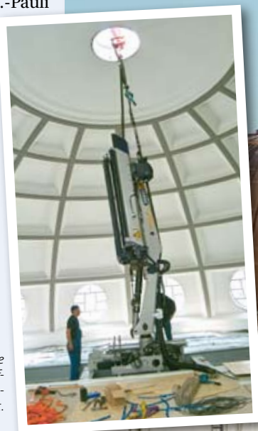
Keine optische Täuschung! Beide Kranteile passten durch die Öffnung im Kuppeldach des Eingangsgebäudes zum Elbtunnel in St. Pauli.
