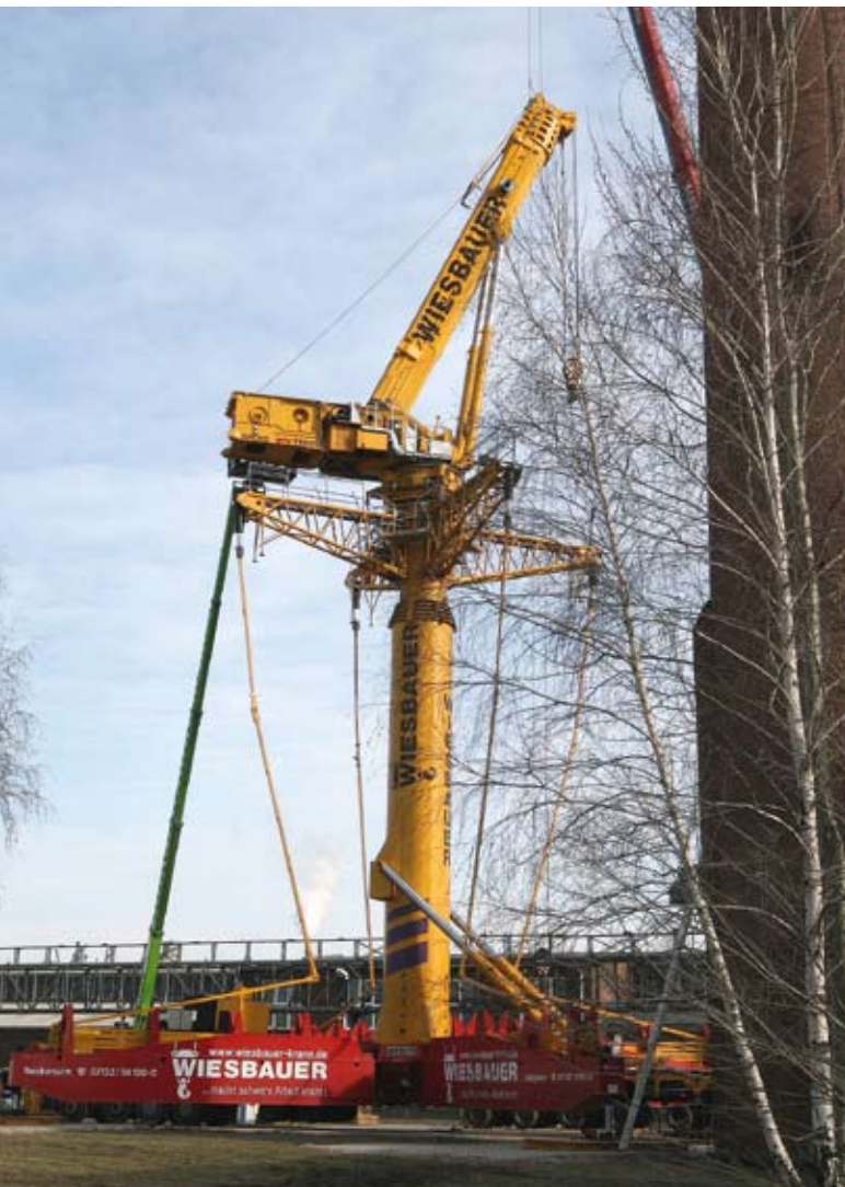
◀ Es geht los: Der Turm des GTK wird austeleskopiert. KM-Bilder
