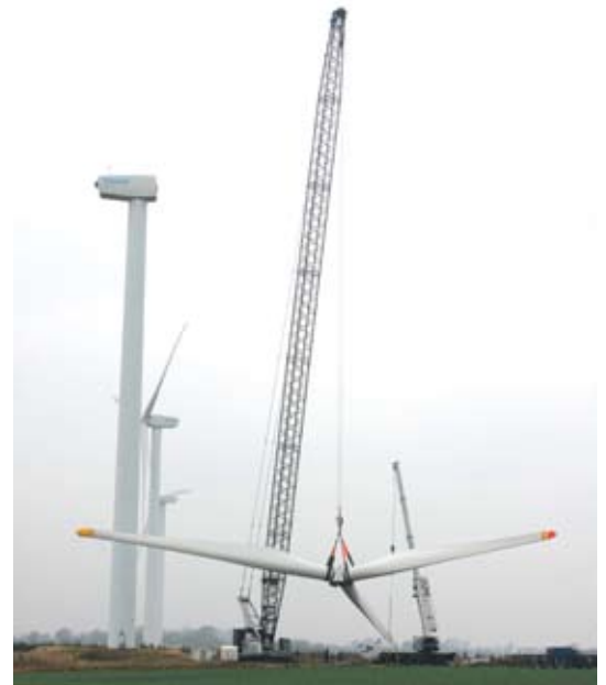
Manitowoc-Raupe Modell 15000 und GMK 5095 im gemeinsamen Einsatz. Gewichte von bis zu 33 t und Ausladungen von 18 m waren hierbei zu bewältigen.
