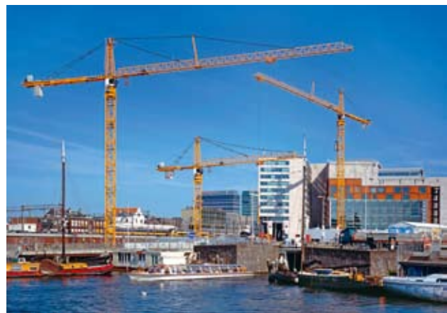
Zur Zeit sind insgesamt vier Liebherr 630 EC-H 40 Litronic in Amsterdam im Einsatz. Weitere Liebherr-Krane sollen folgen.
