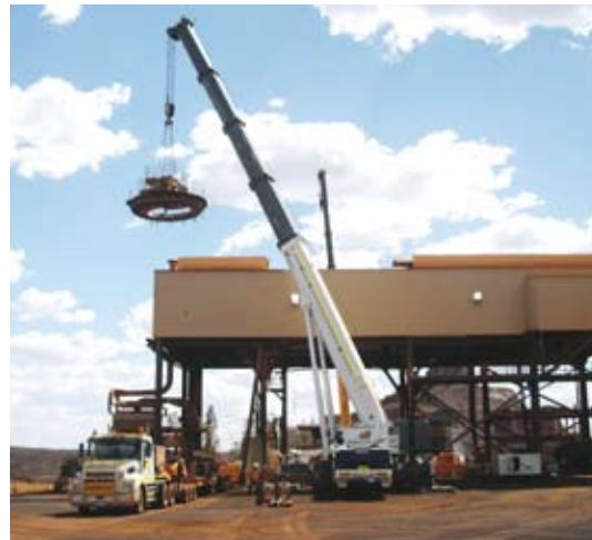
Bei seinem ersten Einsatz demontierte der Grove GMK7450 einen Eisenerzzerkleinerer, der 1969 in Betrieb genommen wurde.
