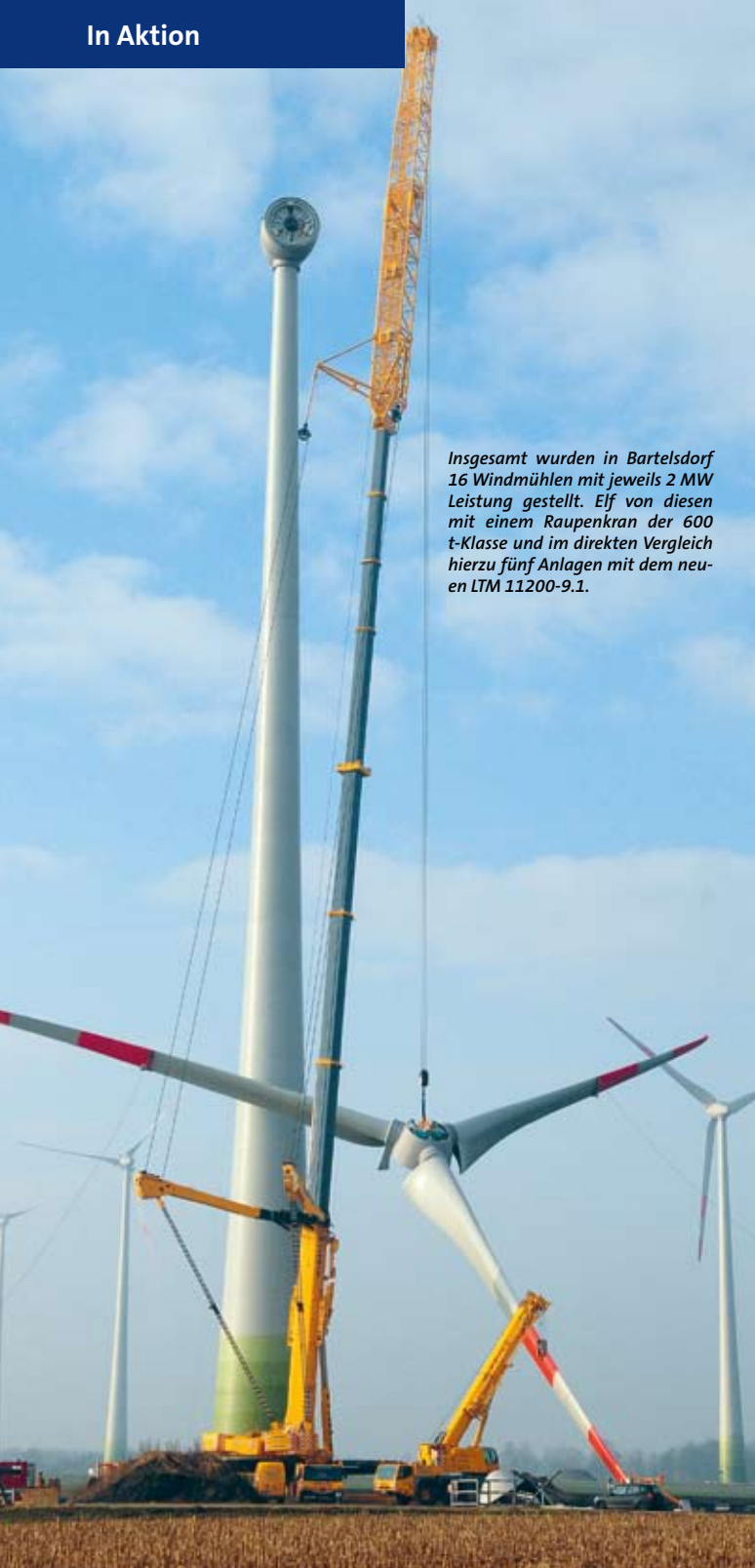
Während der De-/montage sind die Auslegerteile abgestützt.
