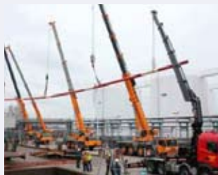
Ivens Transport & Kraanbedrijf ist auf ein größeres Gelände umgezogen.
