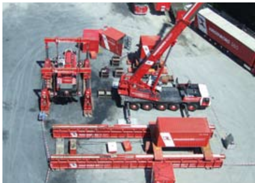
Als Last für das mobile Hubgerüst diente ein Demag-Citykran.
