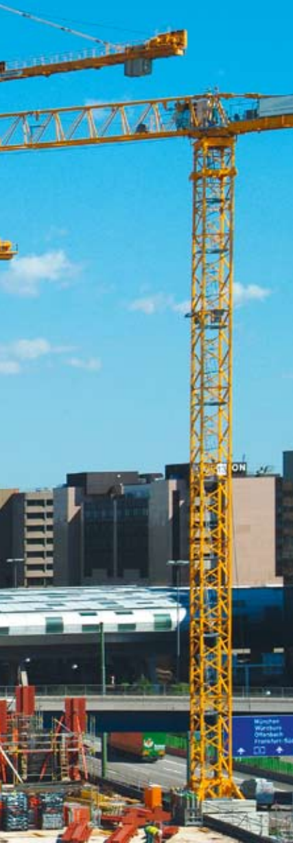
Liebherr EC-H- und EC-B-Krane im Einsatz am Airrail-Center in Frankfurt.
