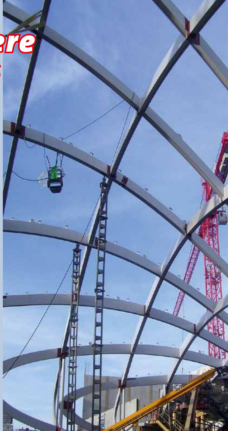
▼▲Die eingesetzten Wolffkrane bieten Maximaltragkräfte von 12 beziehungsweise 25 t Last und werden für den Transport von Fertigbetonteilen eingesetzt.
