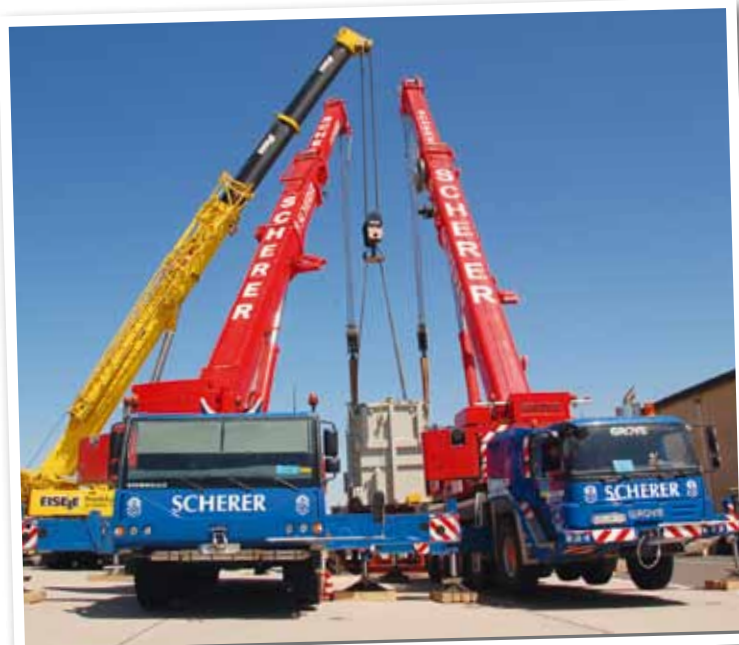
◀ Mit vereinten Kräften wurde der 134,7 t schwere Trafo gehoben.
