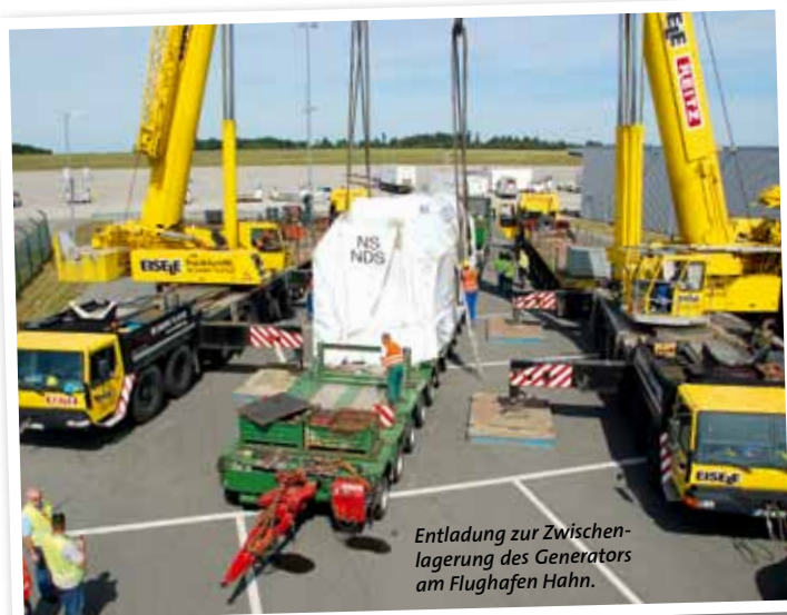
Tridemhub: Wegen fehlender Großkrankapazitäten kam es bei der Entladung des Transformators zu dieser eher ungewöhnlichen Hubkombination.
