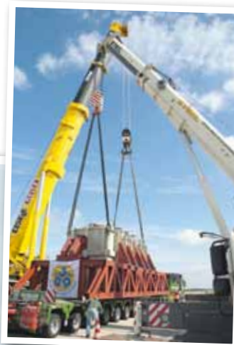
◀▶ Umschlag des Transformators auf die Schwertransporteinheit und Umsetzen der Krane.
