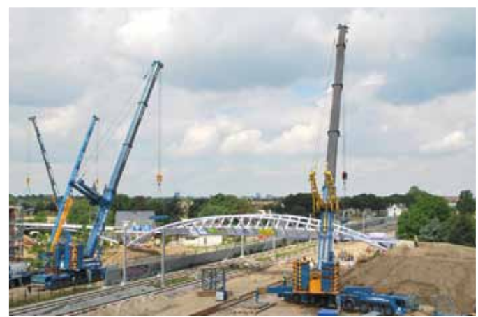
Im Bereich „Kombinierte Techniken“ gewann Sarens Niederlande den Esta Award. Transportiert und montiert wurde eine Brücke, deren Hauptsegment 120 t wog und 56 m lang war.
